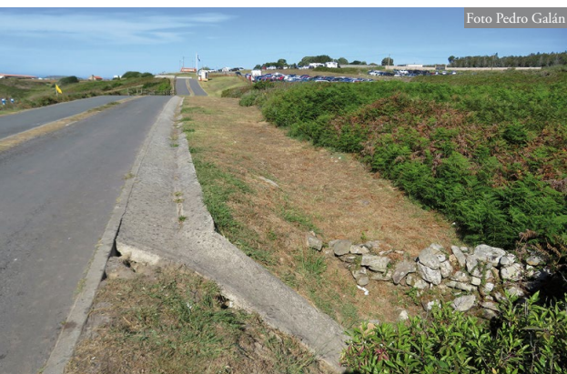
Figura 3: Bajante de hormigón en la cuneta de la carretera sobre la playa de Repibelo (Arteixo, A Coruña), donde se produjo la observación. Son evidentes los orificios de las galerías excavadas por T. lepidus al borde de esta bajante y junto a la carretera. En estas galerías bajo la placa de hormigón se refugia un elevado número de estos lagartos, que probablemente también las utilizan para depositar sus puestas.
